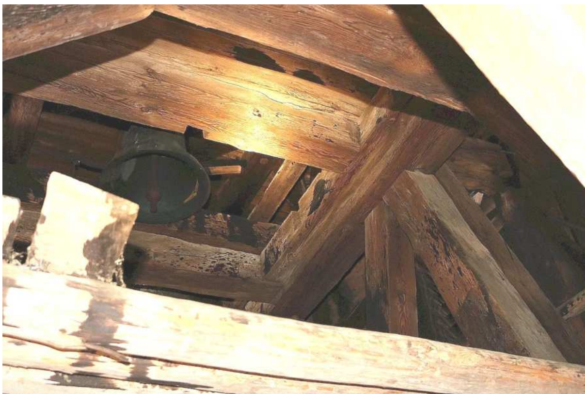
Fot. 9. Konstrukcja drewniana wewnątrz wieży, dzwon.
