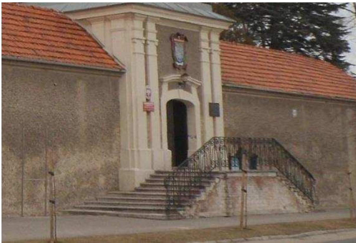
Fot. 17. Schody zewnętrzne od strony wschodniej, główne wejście na krużganki.
