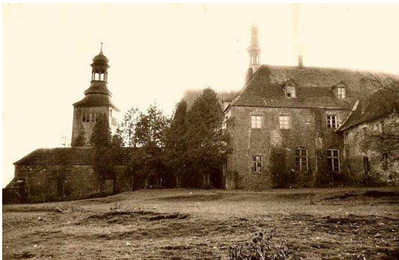
Arch. 06. Kazimierz Biskupi - widok ogólny, elewacja boczna.
