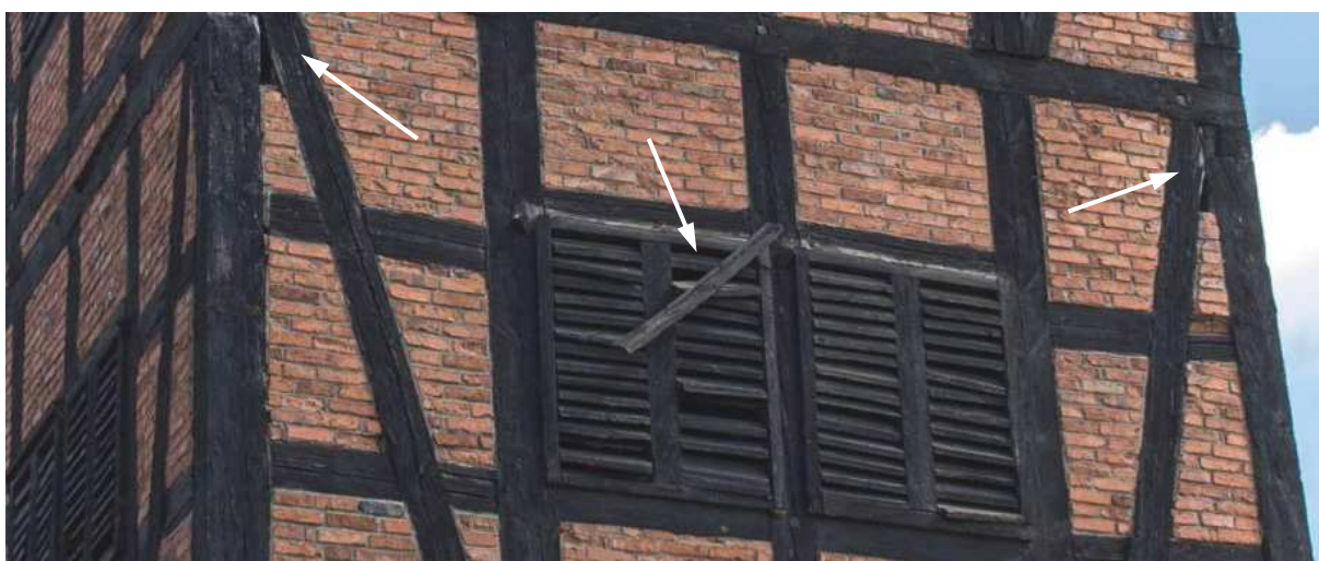
Fot. 4. Fragment muru pruskiego – widoczne prześwity, ubytki cegły, uszkodzone okiennice drewniane.
