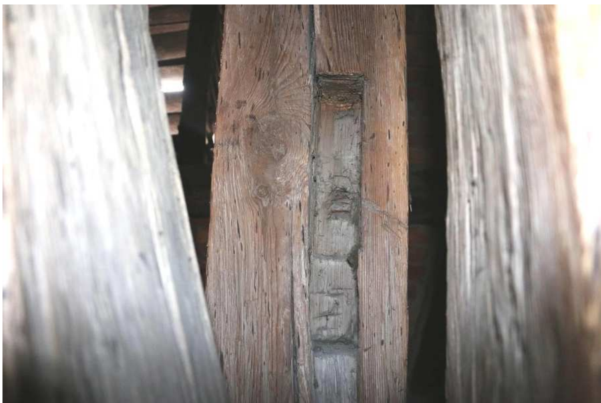
Fot. 11. Konstrukcja drewniana wewnątrz wieży.
