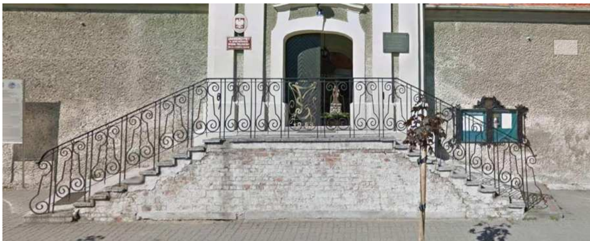
Fot. 18. Schody zewnętrzne od strony wschodniej, ozdobna balustrada kuta.
