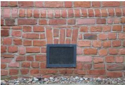
Fot. 2 Otwór przed rozkuciem
